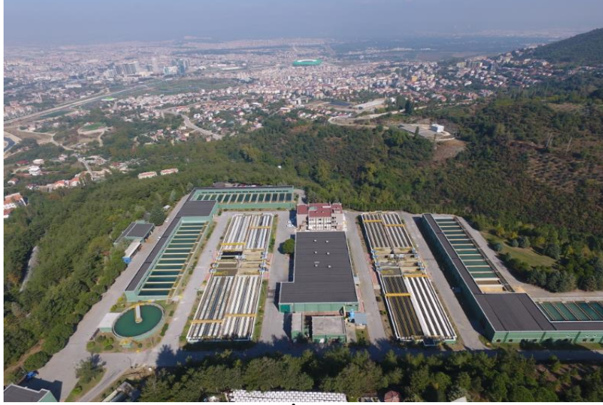
Resim B.1 - Dobruca İçme Suyu Arıtma Tesisi
