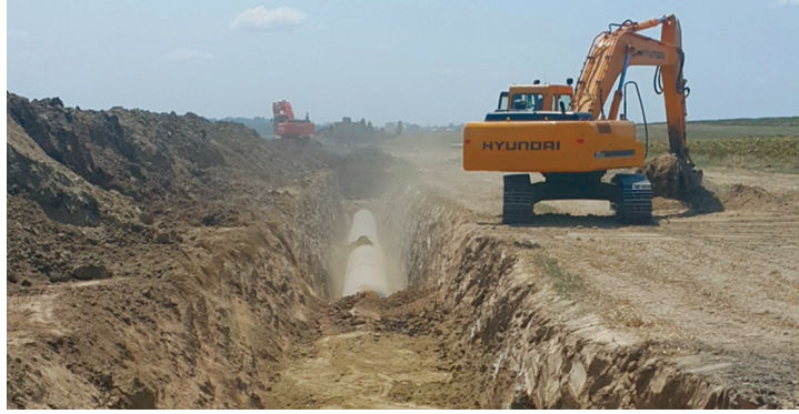
Şekil 14: Karaboru hattı döşeme inşaatı
