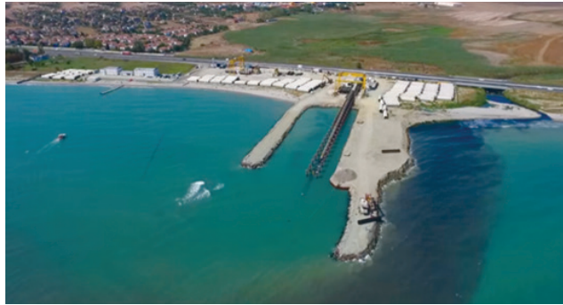
Şekil 15: Derin deniz deşarjı hattı boru daldırma işlemi
